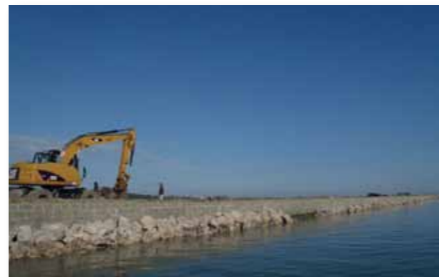
Isti nasip po obnovitvenih delih zagotavlja poplavno varnost v zaledju
